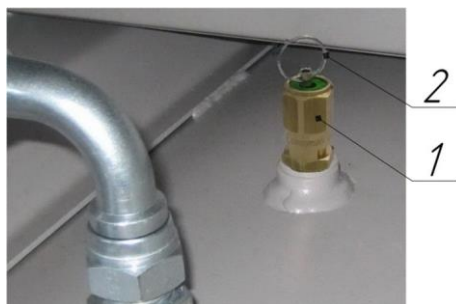
Рисунок 9 – Клапан предохранительный пружинного типа
